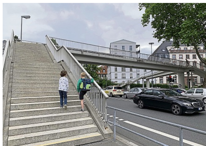
Die Fußgängerbrücke an der Kreuzung Eschersheimer Landstraße / Bremer Straße wird abgerissen. Das polarisiert.
